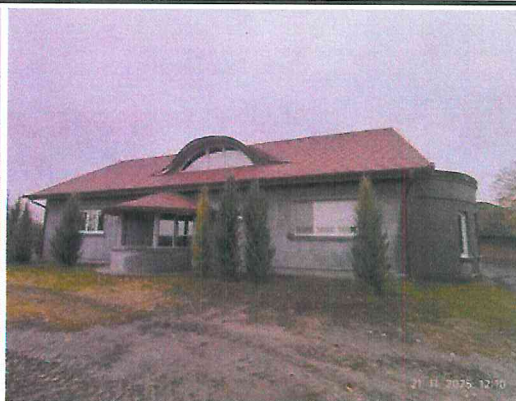
зграда бр.1 - фасада
