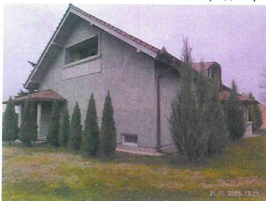
зграда бр.1 - фасада
